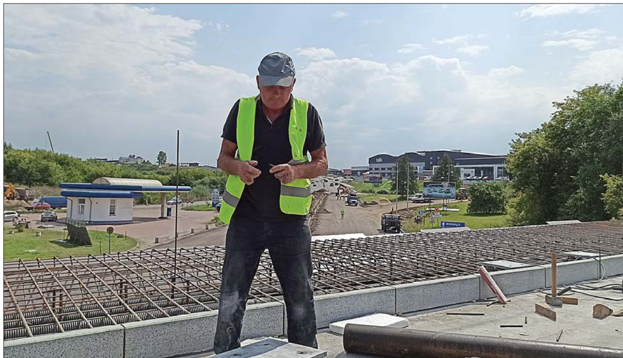
«Велике будівництво» в дії. Ігор Бородайко та його колеги ремонтують міст об'їзної навколо Тернополя.
